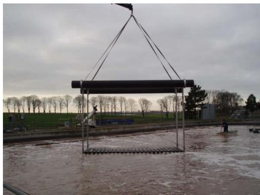
Die Kosten für dieses Belüftungssystem betragen 61.820,50 € brutto für 400 Membran-Plattenbelüfter (Material EPDM), fünf Edelstahl-Belüftungsgitter incl. Lieferung und Montage.
