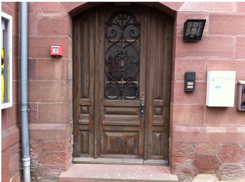
Im Sockelbereich des hinter der Tür befindlichen Treppenhauses sind Feuchteschäden zu erkennen. Ursächlich dürfte hierfür die mangelnde Dichtigkeit der Türe sein. Der Austausch der Türe sollte deshalb im Rahmen eines sachgerechten Gebäudeunterhalts erfolgen. Die hierfür vorliegenden Angebote stellen sich wie folgt dar:
